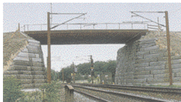
Estribo de puente reforzado.
