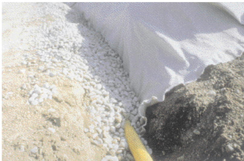
La función filtro y flexibilidad son criterios decisivos en el diseño en aplicaciones como dren.
