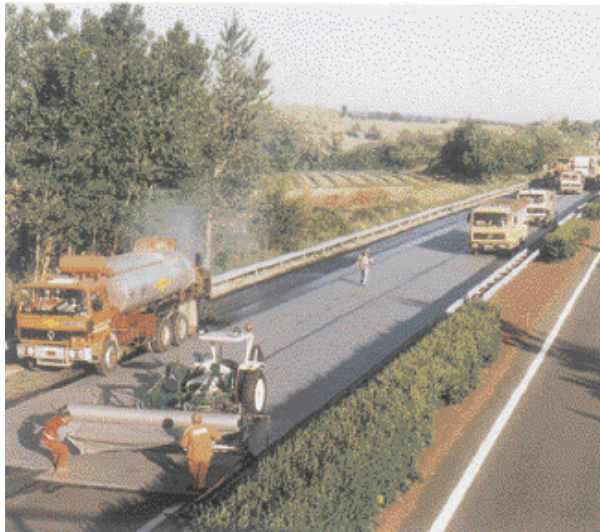
Geotextil aplicado en la renovación de carreteras deterioradas.
