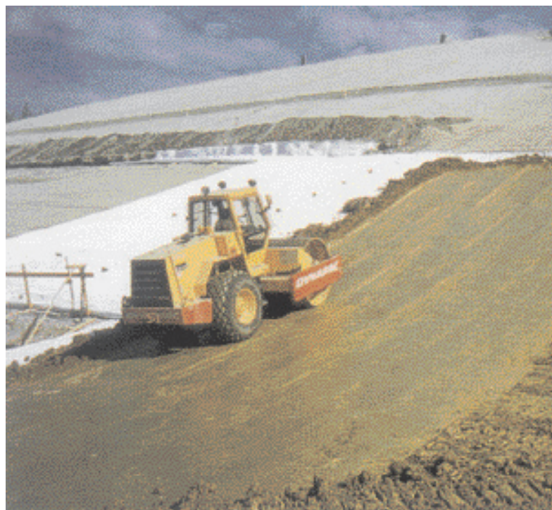
Operación de refuerzo de terraplén en un vertedero.
